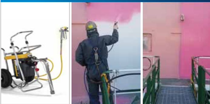
Airless Spray 도포
